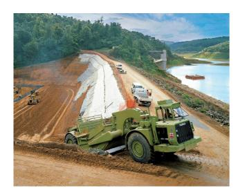
41M HIGH, ZONED **EARTHFILL DAM 36M DEEP EXCAVATION FACE ZERO LTIS** 300,000M3 OF FILL **REPLACED**
